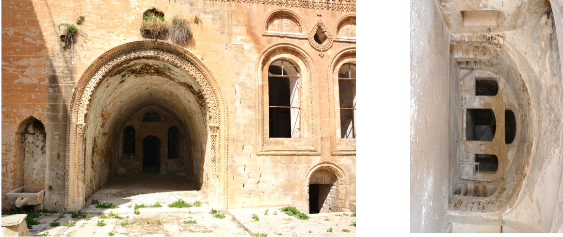
Görsel 5. İkinci kat ve geometrik motifli eyvan kemeri (solda) ve tavan süslemeleri ve seki oluşumu (sağda)
