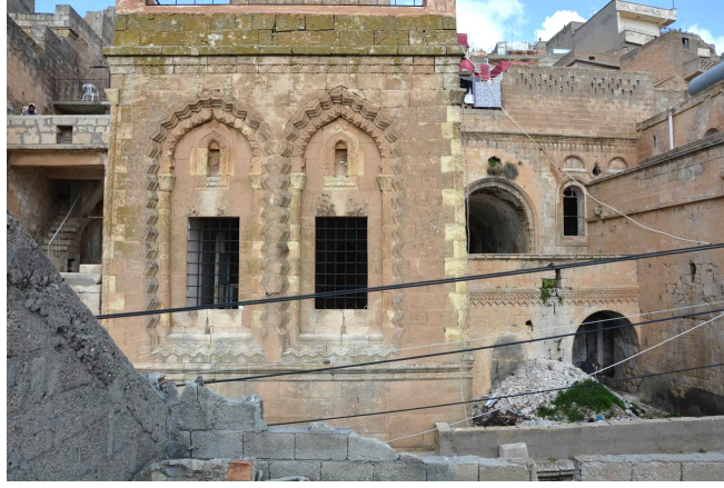
Görsel 8. İkinci kat pencere açıklıkları ve cephe süslemeleri
